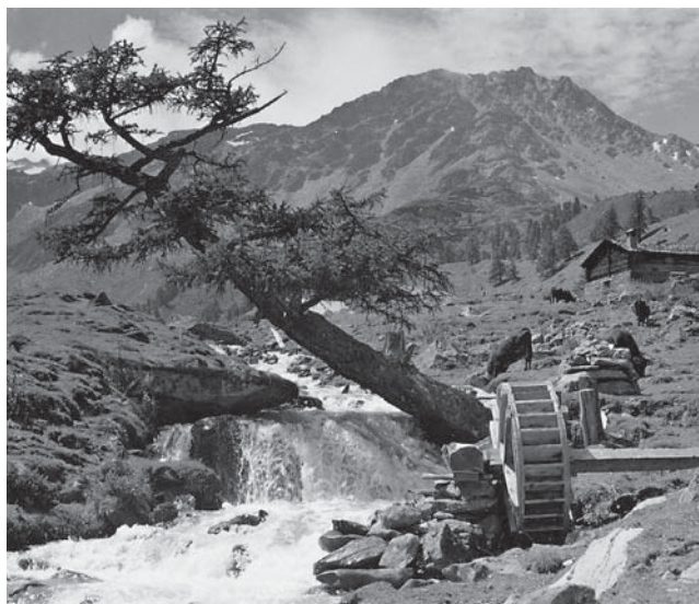
La scie à eau qui permet de construire les nouvelles étables de Tortin.
